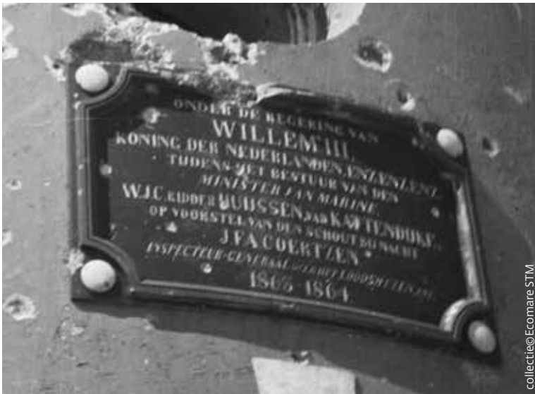
Detail met de beschadigde plaquette.
