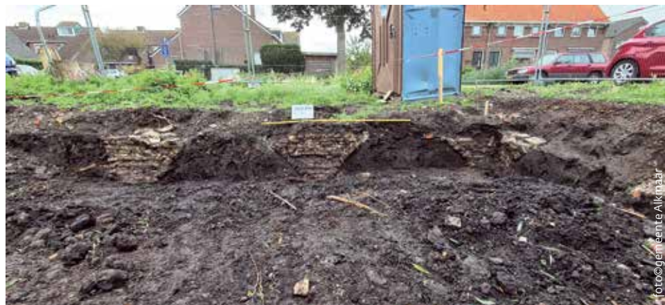
Spaarboogfundering van de voor- en zijgevel.
