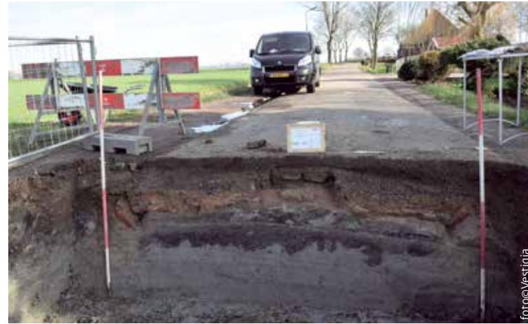
Reguliere opbouw van het wegdek met aan de basis de karresporen.
