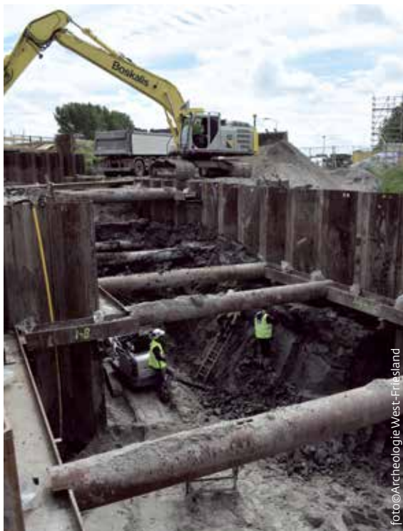
Werkomstandigheden in de bouwkuip.
