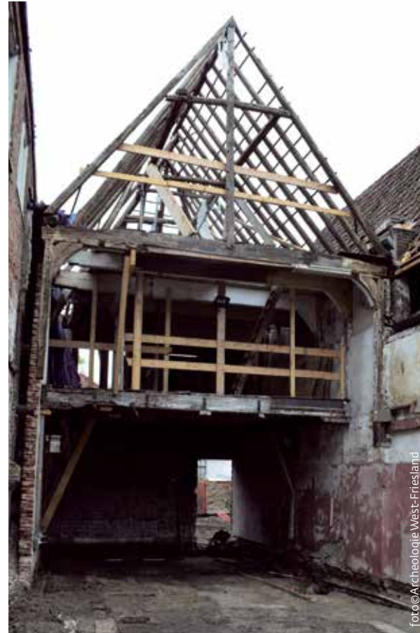
Een blootgelegd sporenvlak op perceel Nieuwland 16, met op de achtergrond het achterhuis uit 1630-1635. Het smallere voorhuis is afgebroken en in dezelfde vorm teruggebouwd.
