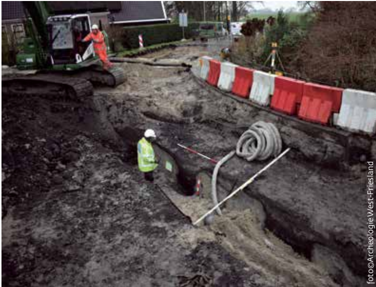
Daliegaten uit de 12de of vroege 13de eeuw, zichtbaar in de rioolsleuf die ter hoogte van het kruispunt Hemmerbuurt-Meeweg uitgegraven is.
