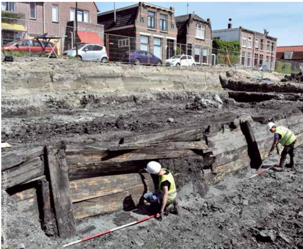
Een deel van de beschoeiing van de noordzijde van de haven, die bestaat uit eikenhouten palen en grenenhouten planken.
